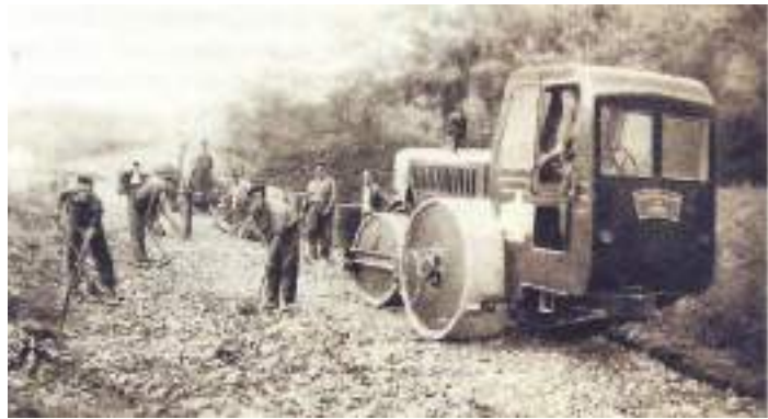
Peones camineros de la Diputación. El traspaso de más de 600 Km. de carreteras al Estado obligó a reorganizar el servicio en muchos de los "trozos" en que se dividía su distribución a lo largo y ancho de la provincia.
