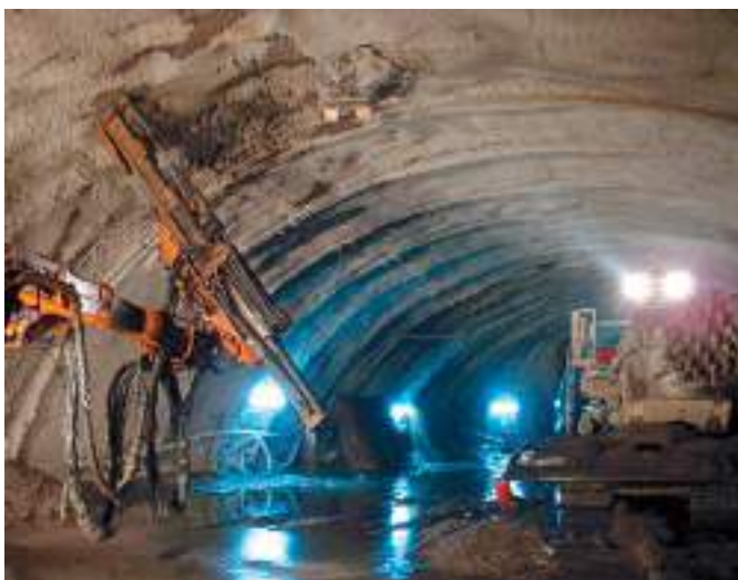
Una vieja aspiración de los vizcaínos (y sobre todo bilbaínos) se comenzó a ver como posible y realizable en estos momentos. El Metro de Bilbao, con décadas de planes y planos fallidos comenzaba a construirse.
