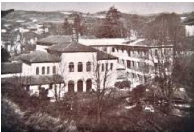
Sanatorio de Zaldibar, en medio de sus obras de ampliación de 1943.
