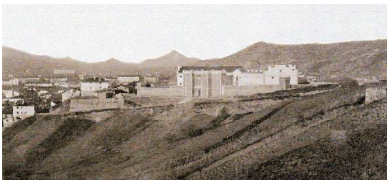
La cárcel de Larrinaga, en Solokoetxe, fue una entidad modelo en su momento. Inaugurada en 1876, la Diputación invirtió cuantiosas sumas en su construcción y mantenimiento, aunque antes de la Guerra ya se anunciaban sus problemas de saturación.
