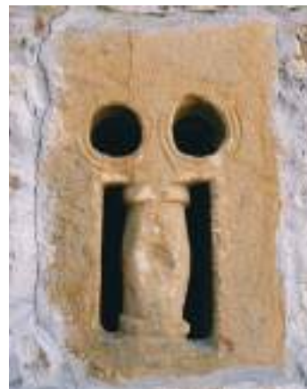
Ventana prerrománica (siglo X) reutilizada en los muros de la ermita de San Lorenzo de Isla (Gautegiz de Arteaga).
